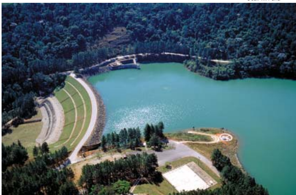
Barragem Paiva Castro, na divisa entre os municípios de Caieiras e Franco da Rocha: última das cinco barragens que compõem o Sistema Cantareira
