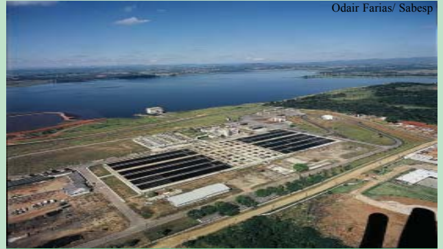
Vista aérea da ETA de Taícupeba, divisa entre Mogi das Cruzes e Suzano
